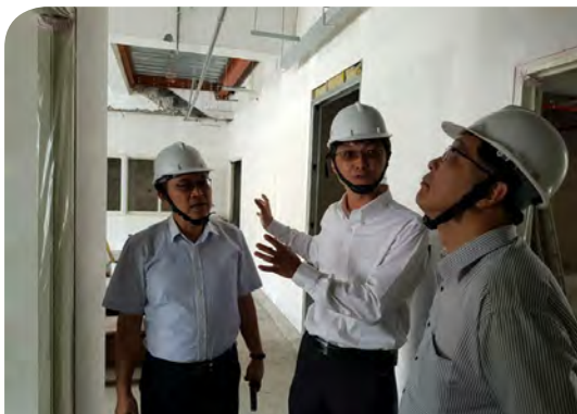
■ 鄭署長銘謙至六合營區辦公廳舍施工現場視察
