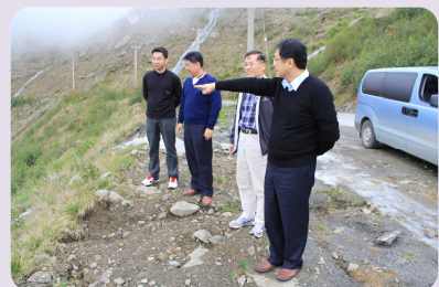
曾文水庫上游二萬坪崩塌地段[101.2.23]
